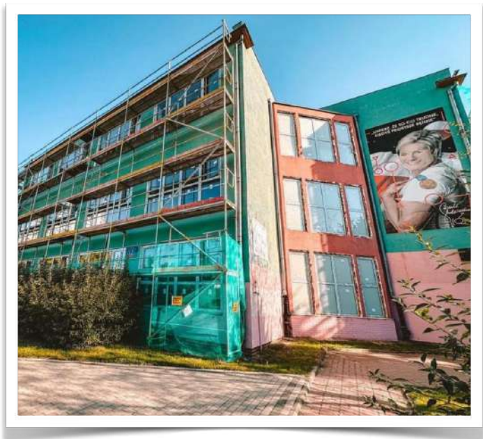
Rys. 8- budynek w trakcie wymiany okien
