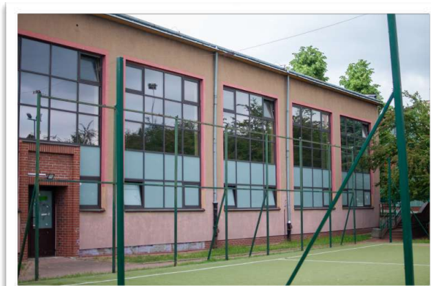
Rys. 3 - widok elewacji sali gimnastycznej
