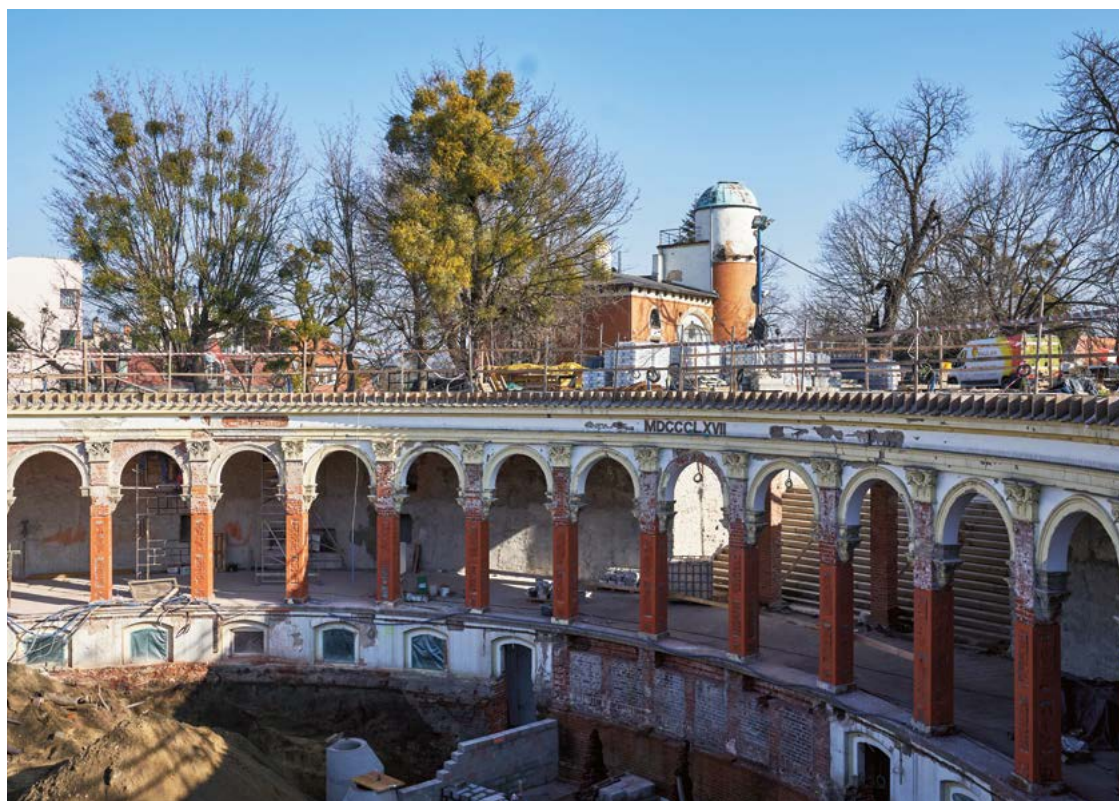
Pierwszy etap rewaloryzacji bastionu Sakwowego powinien zakończyć się w ostatnim kwartale 2023 roku
